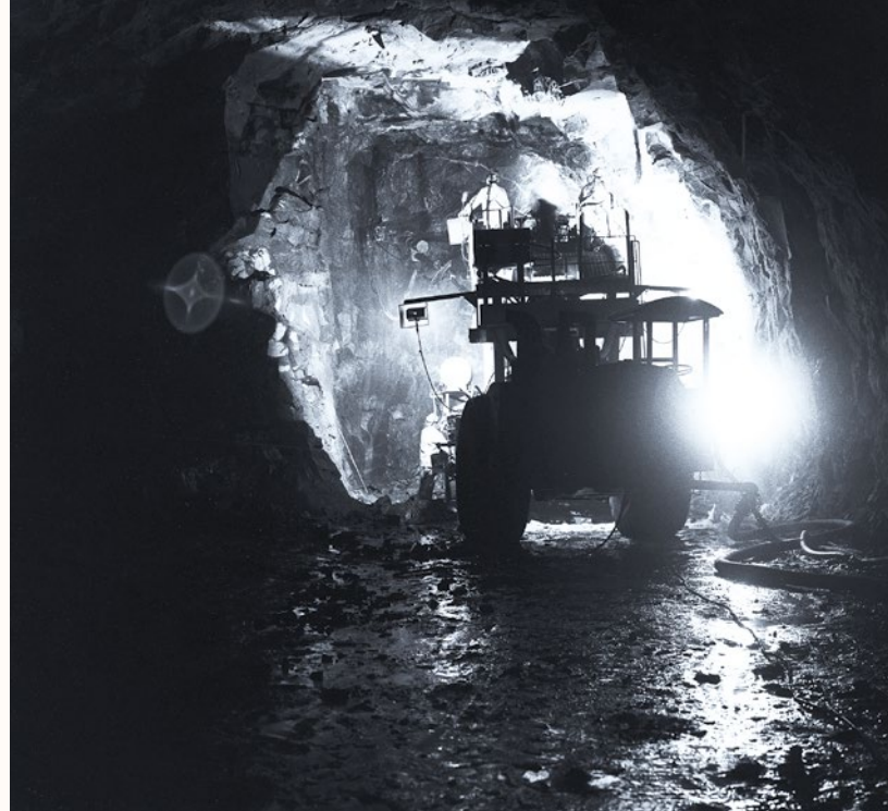
CREUSAGE D'UNE GALERIE SOUTERRAINE, MANIC 3, 1975. Centre d'archives Hydro-Québec, série H1-700-965.
