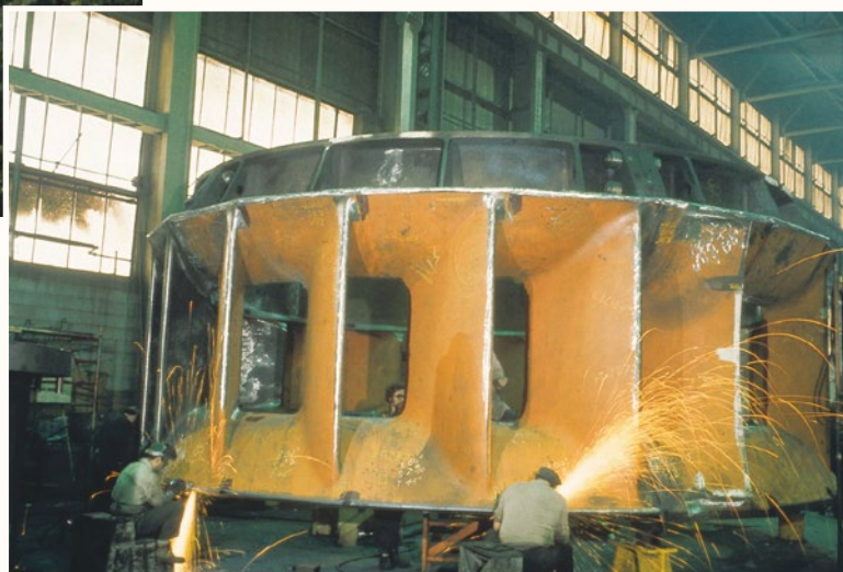
INSTALLATION D'UNE TURBINE HYDRAULIQUE, MANIC 5, INAUGURÉE EN 1968. Centre d'archives Hydro-Québec, série H1-701-207.
