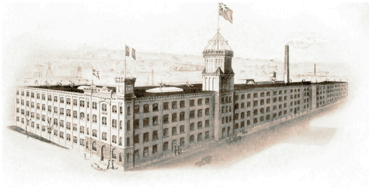
BÂTIMENT DE LA DOMINION CORSET, FONDÉE EN 1886, QUI DEVIENDRA L'ÉDIFICE LA FABRIQUE ET ABRITERA L'ÉCOLE DES ARTS VISUELS DE L'UNIVERSITÉ LAVAL EN 1993.
