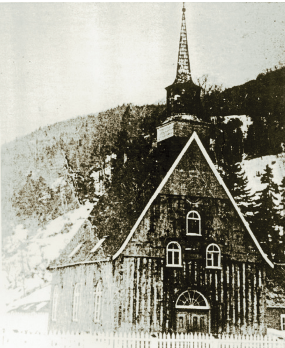
DEUXIÈME ÉGLISE DE PETITE-RIVIÈRE-SAINTE-FRANÇOIS, CONSTRUITE EN 1777 ET DÉMOLIE EN 1903. ELLE AVAIT DES MURS EN COLOMBAGE PIERROTTÉ. Inventaire des biens culturels du Québec.
