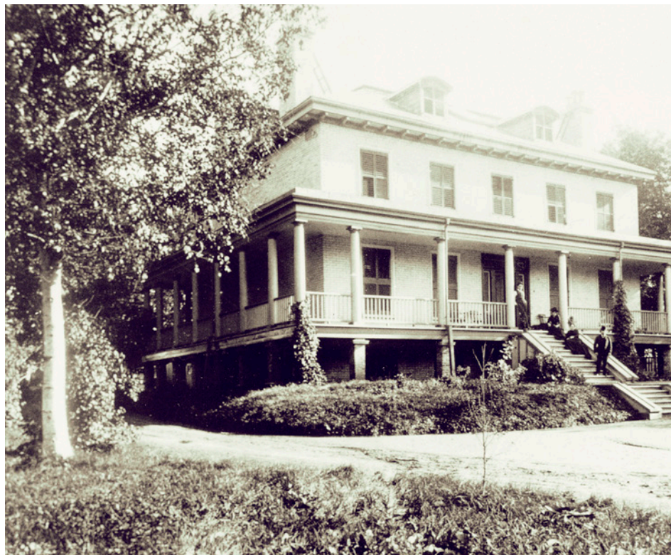
VILLA TEVIOT, VERS 1891. Archives de la Ville de Québec, L.-P. Vallée, négatif n° 16195. Construite en 1849-1850, la villa Teviot, située le long du chemin Sainte-Foy, s'inscrit dans l'esprit néoclassique. Cette villa fut démolie en 1936.
