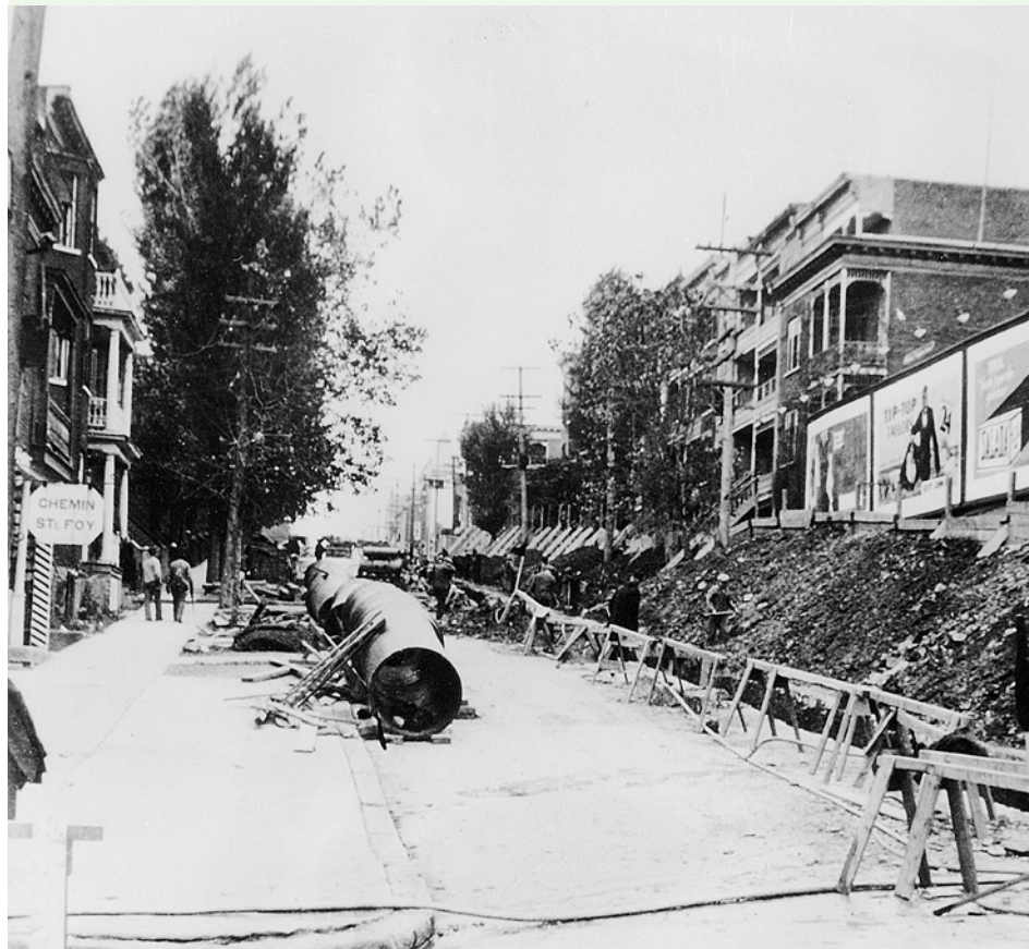
TRAVAUX D[É] L'AQUEDUC, QUARTIER MONTCALM-SAINTE-SACREMENT, VERS 1940.
