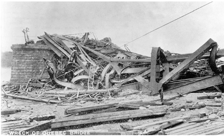
LES RUINES DU PONT DE QUÉBEC APRÈS SON EFFONDREMENT EN 1907. Archives de la Ville de Québec, négatif n° 10248.
