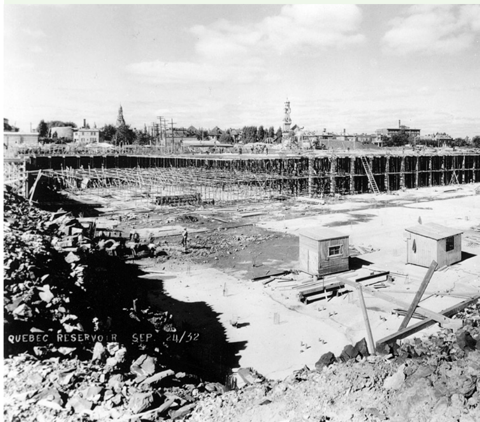
LE « LAC SOUS LES PLAINES », CONSTRUCTION DU RÉSERVOIR D'EAU SOUTERRAIN DE LA VILLE SUR LES PLAINES D'ABRAHAM, 1932.
