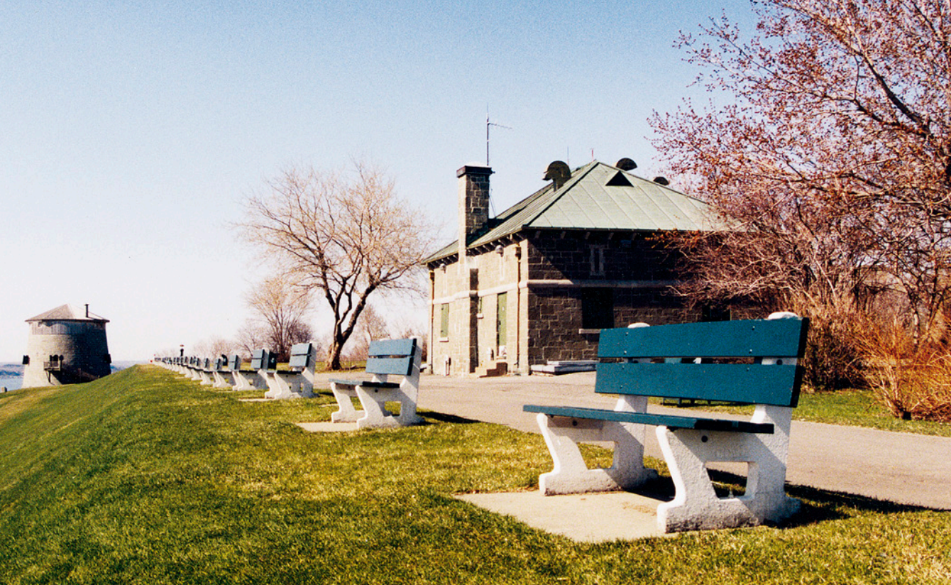
LE RÉSERVOIR D'EAU DE LA VILLE DE QUÉBEC, CONSTRUIT EN SOUTERRAIN AUX PLAINES D'ABRAHAM, FAÇONNE LE PAYSAGE DES COVE FIELDS.
