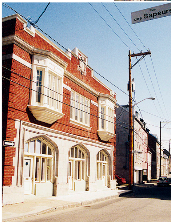
EN 1984, L'ÉDIFICE AYANT ABRITÉ LE POSTE DE POLICE ET LA CASERNE DE POMPIERS N° 6, SUR LA RUE CHAMPLAIN (1912), A ÉTÉ RÉAMÉNAGÉ EN COOPÉRATIVE D'HABITATION. Photographie Claude Bélanger.
