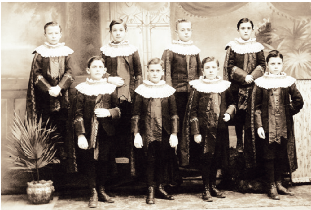
SANCTUAIRE DE SAINT-SAUVEUR, 1907.
