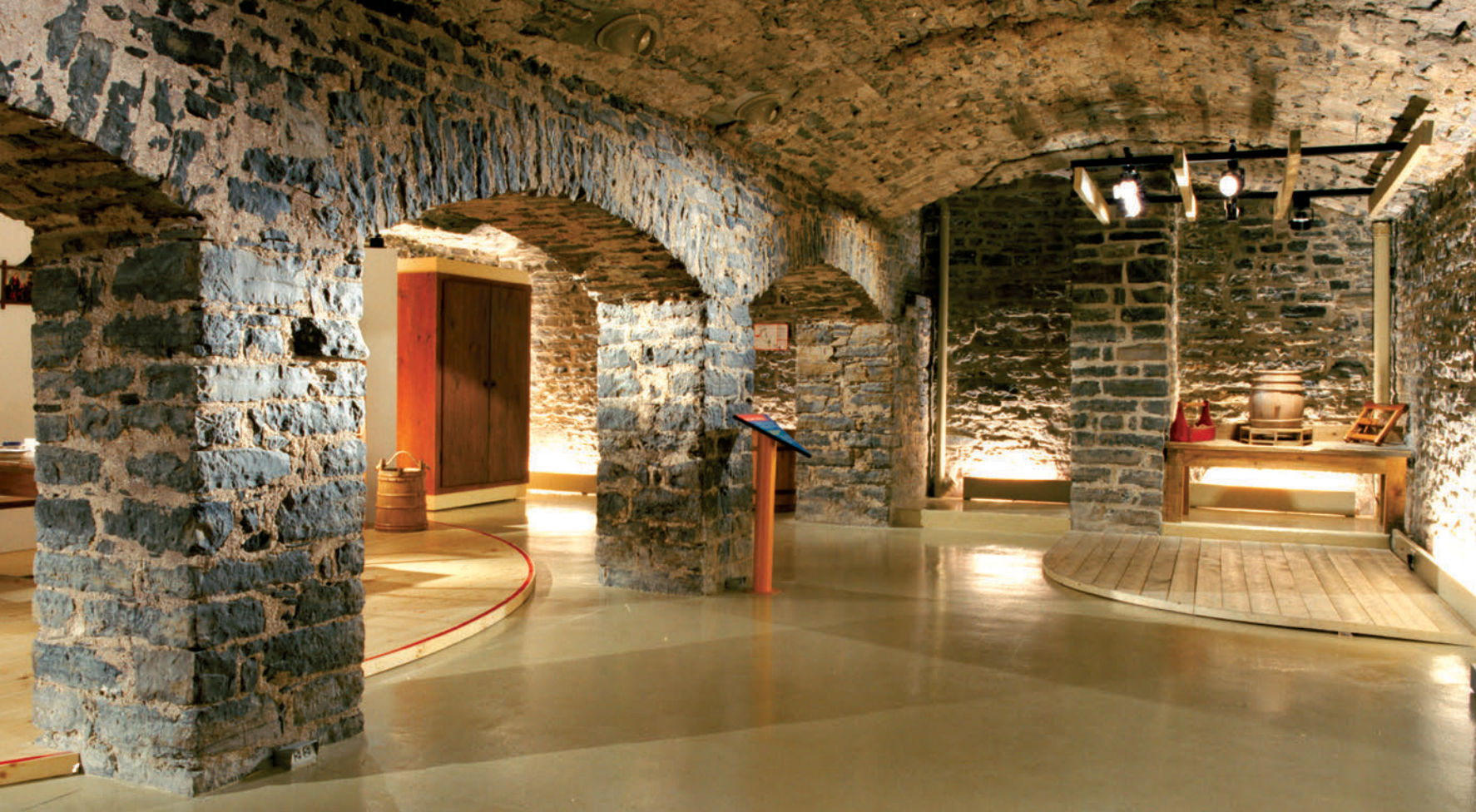
▲ Les voûtes du Centre d'interprétation de Place-Royale, dans la maison Hazeur, ont été érigées en 1684-1685 par le maçon Jean le Rouge. Élément architectural complexe à réaliser, elles se composent d'appuis, les piédroits, qui supportent les charges horizontales et verticales, et d'un berceau, qui peut être doublé lorsque la portée est trop longue.
