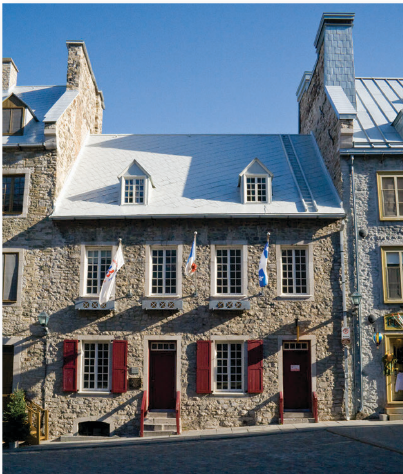
◀ Donnant directement sur la Place-Royale à Québec, la maison Fornel est construite en 1658 pour Louis Rouer de Villeray, administrateur colonial et commis de la Compagnie de la Nouvelle-France. Acquisée par le marchand Louis Fornel en 1713, elle reste dans le patrimoine familial jusqu'à la fin du XVIII e siècle. Incendiée et reconstruite à trois reprises, classée monument historique en 1964, elle est restaurée dans le cadre du chantier de Place-Royale pour lui redonner son apparence de la fin du Régime français. © Émilie Lapierre Pinal / CIEQ, 2007, Q03-26
