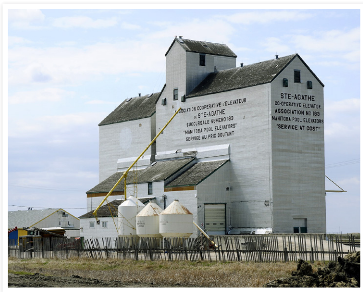
FIGURE 8 ANCIEN SILO À GRAINS DE SAINTE-AGATHE AU MANITOBA, 2009 Bernie Freeman. Manitoba Historical Society, 5145 .
